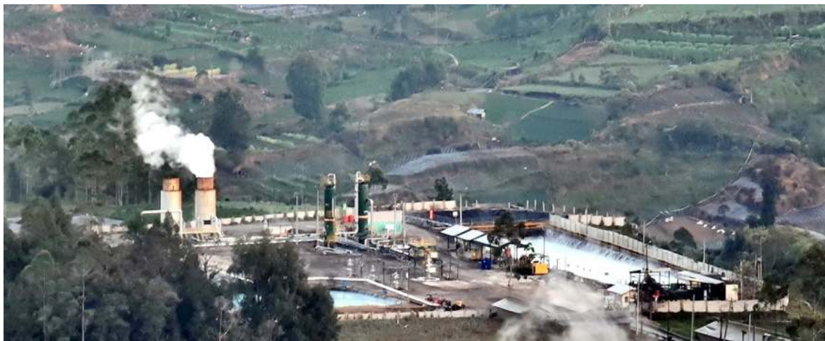
Kolam pengendapan silika di PLTP Dieng, dengan brine mengandung litium kadar tinggi
