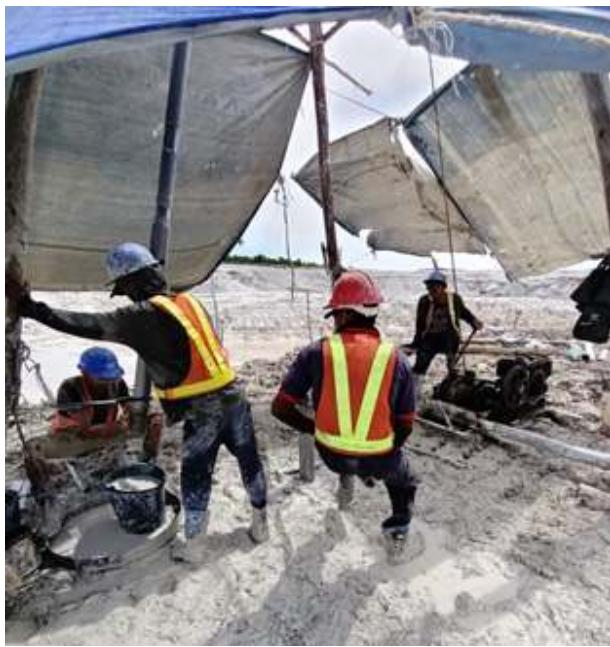
Gambar 2. Proses mengeluarkan material dari *bailer* ke dalam ember
